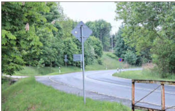
Der Mildenitzer Berg von der Seekurve aus, rechts das alte Geländer bei Überquerung des Hechtgrabens Foto: R. Stapel, 28.5.13
