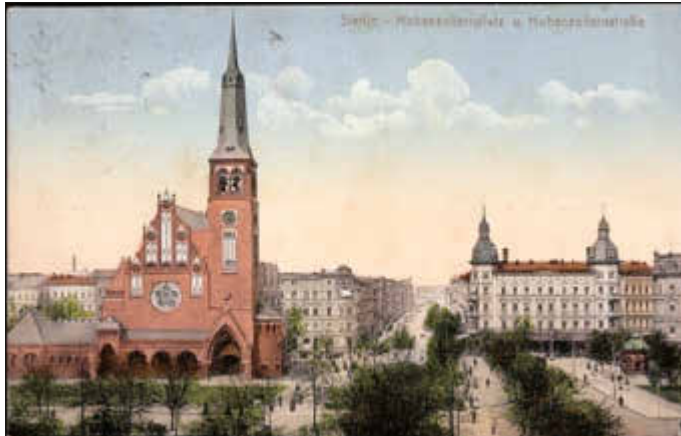
Die Hohenzollernstraße in Stettin
