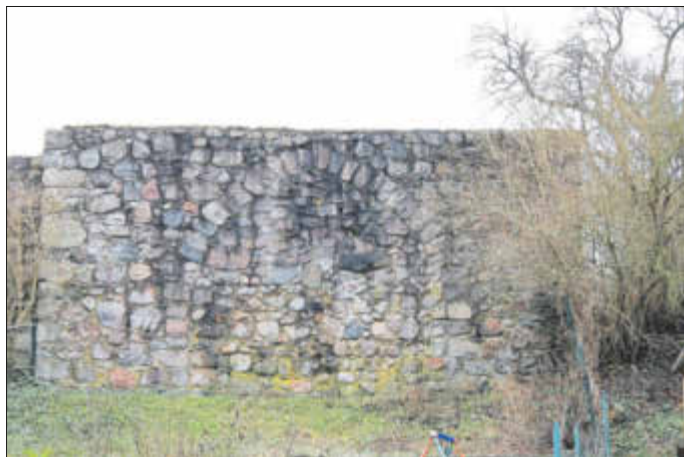
Der Turmstumpf des ehemaligen Burgtores mit zugemauerter Durchfahrt von der Stadtseite aus Foto: R. Stapel, 11.1.15
