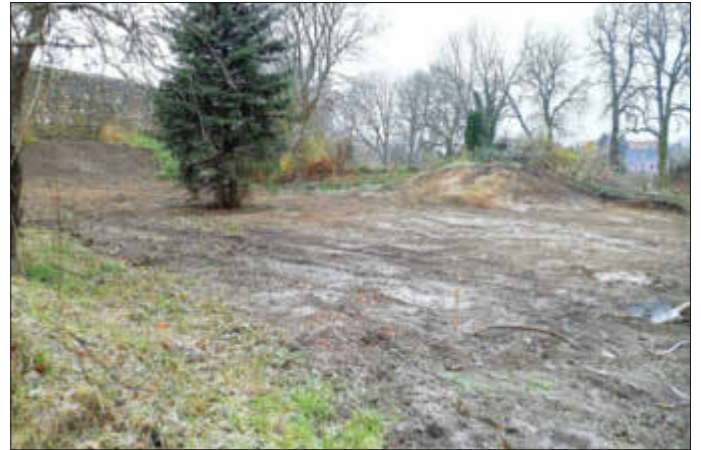
Der durch unberechtigte Erdarbeiten angeschnittene Teil des Ratsmännerwalls am Eichberg ist gut im Profil zu erkennen. Zwischen Stadtmauer und Wall verlief ursprünglich ein weitaus tieferer Graben. Foto: R. Stapel, 3.12.17
