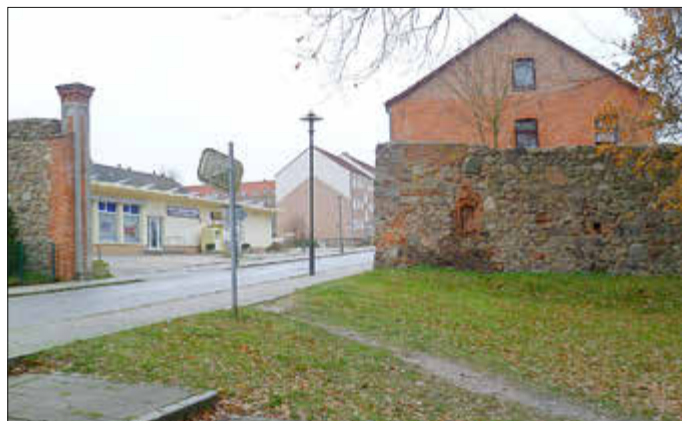
Derzeitiger Zustand am Standort des früheren Neutores, an das noch der Zier-Pfeiler links erinnert. Sein Gegenstück auf der anderen Straßenseite wurde 1957 mit abgerissen. Als Überbleibsel des 1945 niedergebrannten Torschreiberhauses erkennt man in der Stadtmauer rechts der Straße noch zwei vermauerte Fensteröffnungen. Der Giebel jenseits der Stadtmauer ist der vom Haus Neutorstraße 13. Foto: Roland Stapel, 3.12.2017
