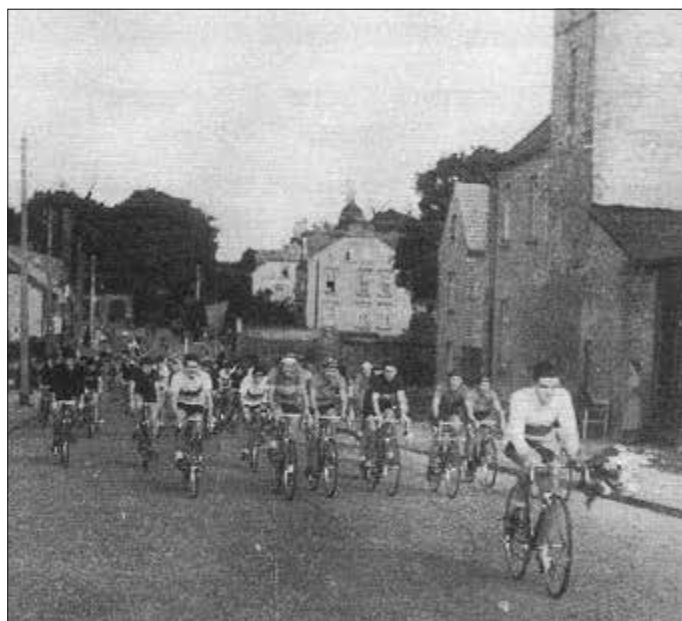
Ehrenrunde um Woldegk in der Ernst-Thälmann-Straße, kurz vor dem Abzweig Krumme Straße / Klosterstraße in Höhe des heutigen 5-Geschossers
