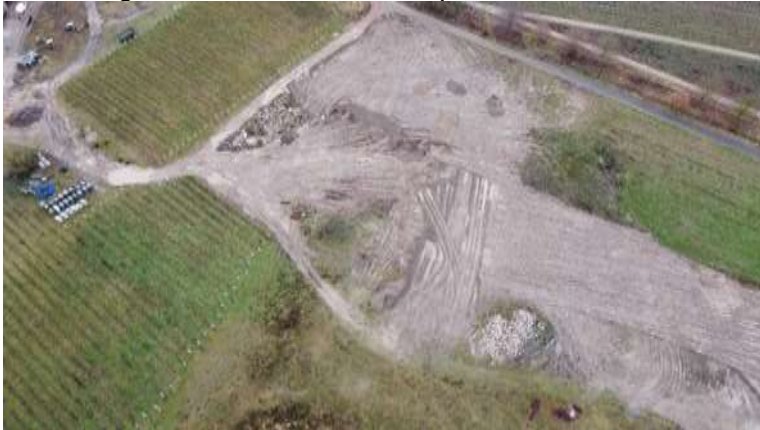
Abbildung 5: aktuelles Luftbild Deponie
