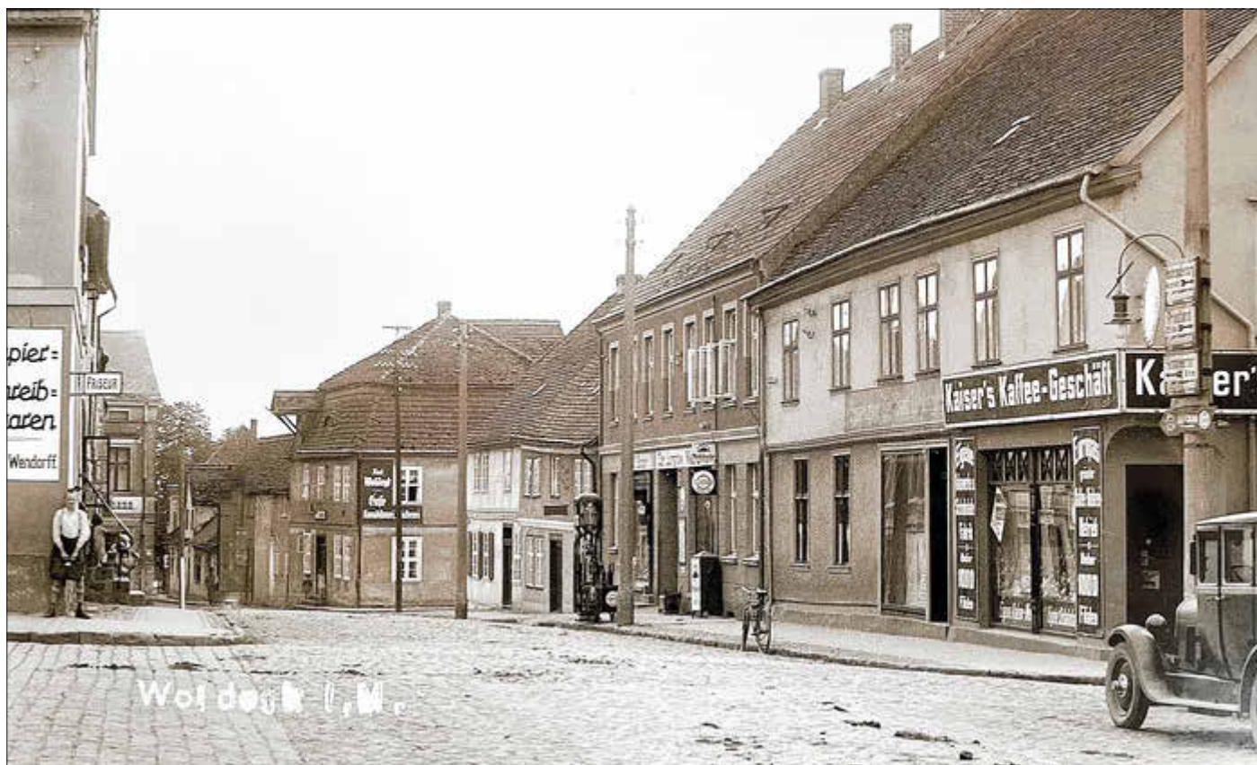
Blick vom Marktplatz in die Neutorstraße. Die Gebäude der rechten Straßenseite fielen innerhalb der Stadtmauern sämtlich dem Großbrand 1945 zum Opfer. Die Hausecke links ist die des heutigen „Harry's Eiscafé“. Das Gebäude der Bäckerfamilie Woldegk („Karl Woldegk - Café, Konditorei, Bäckerei“) ist das markante Haus Neutorstraße / Ecke Goldberg. Ansichtskarte, 1930er Jahre.
